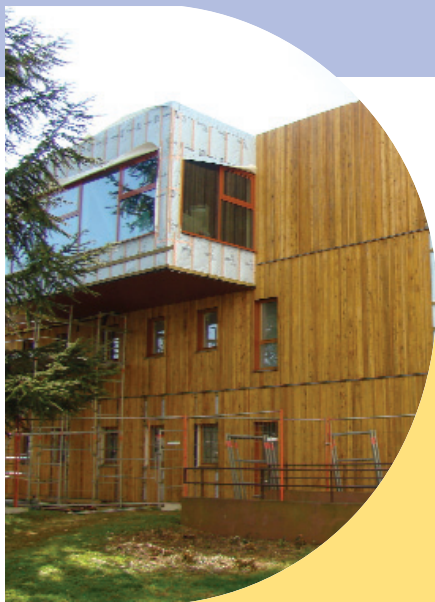
Construction bâtiment bois
