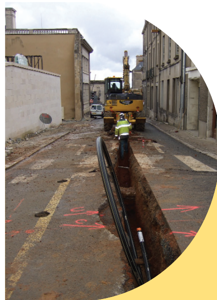
Chantier de rénovation d'une canalisation de gaz
