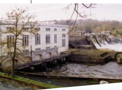
Barrage de Jousseau
